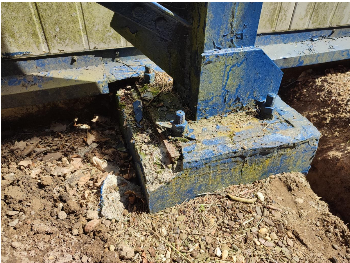
Fot.6 Przykładowe uszkodzenia głowicy trzpienia stopy fundamentowej
