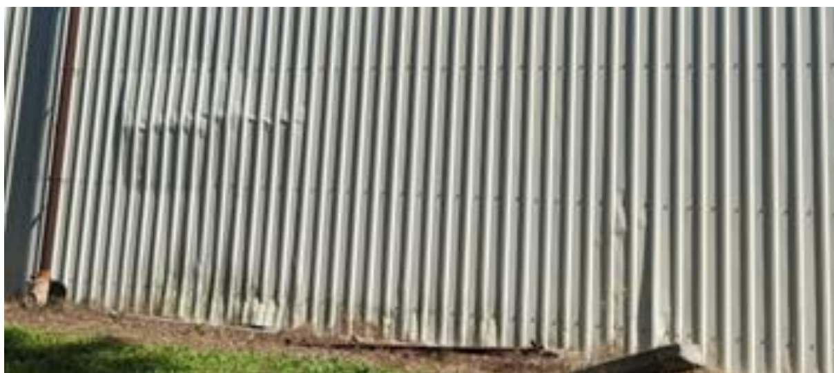
Fot. 14 Przykład uszkodzeń blachy trapezowej obudowy w części południowej
