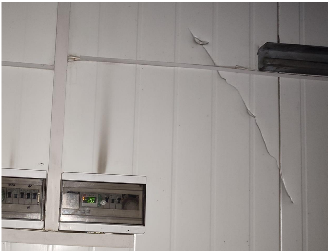
Fot. 15 Przykład uszkodzeń płyt w części chłodni
