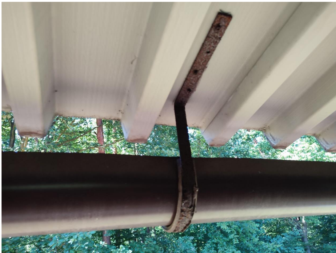
Fot. 16 Korozja uchwytów rynien. Rynny zlokalizowane wgłębi krawędzi pokrycia
