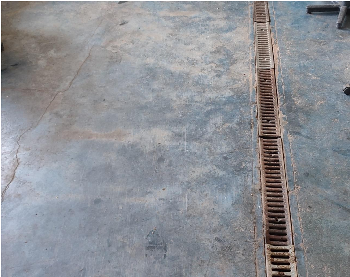
Fot.8 Przykładowe pęknięcia posadzki w obrębie wpustów
