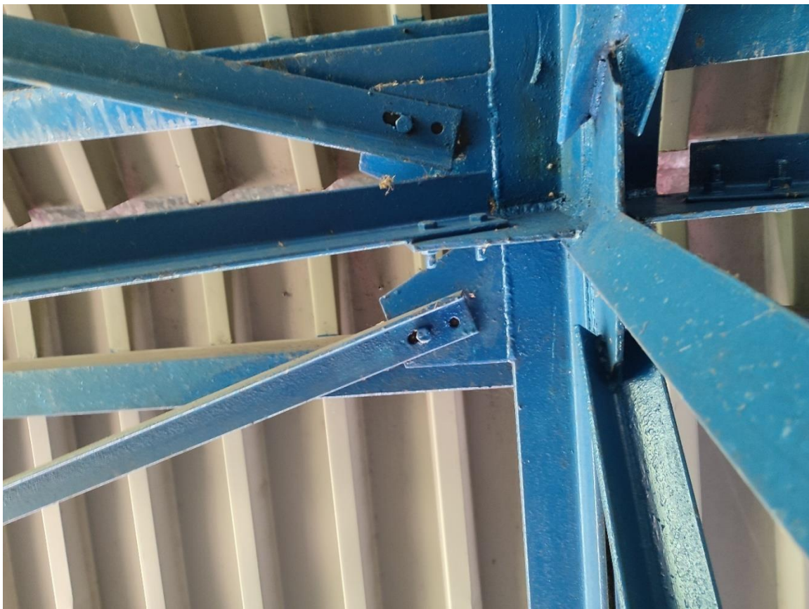
Fot.12 Przykład braku śrub w połączeniu stężenia połaciowego
