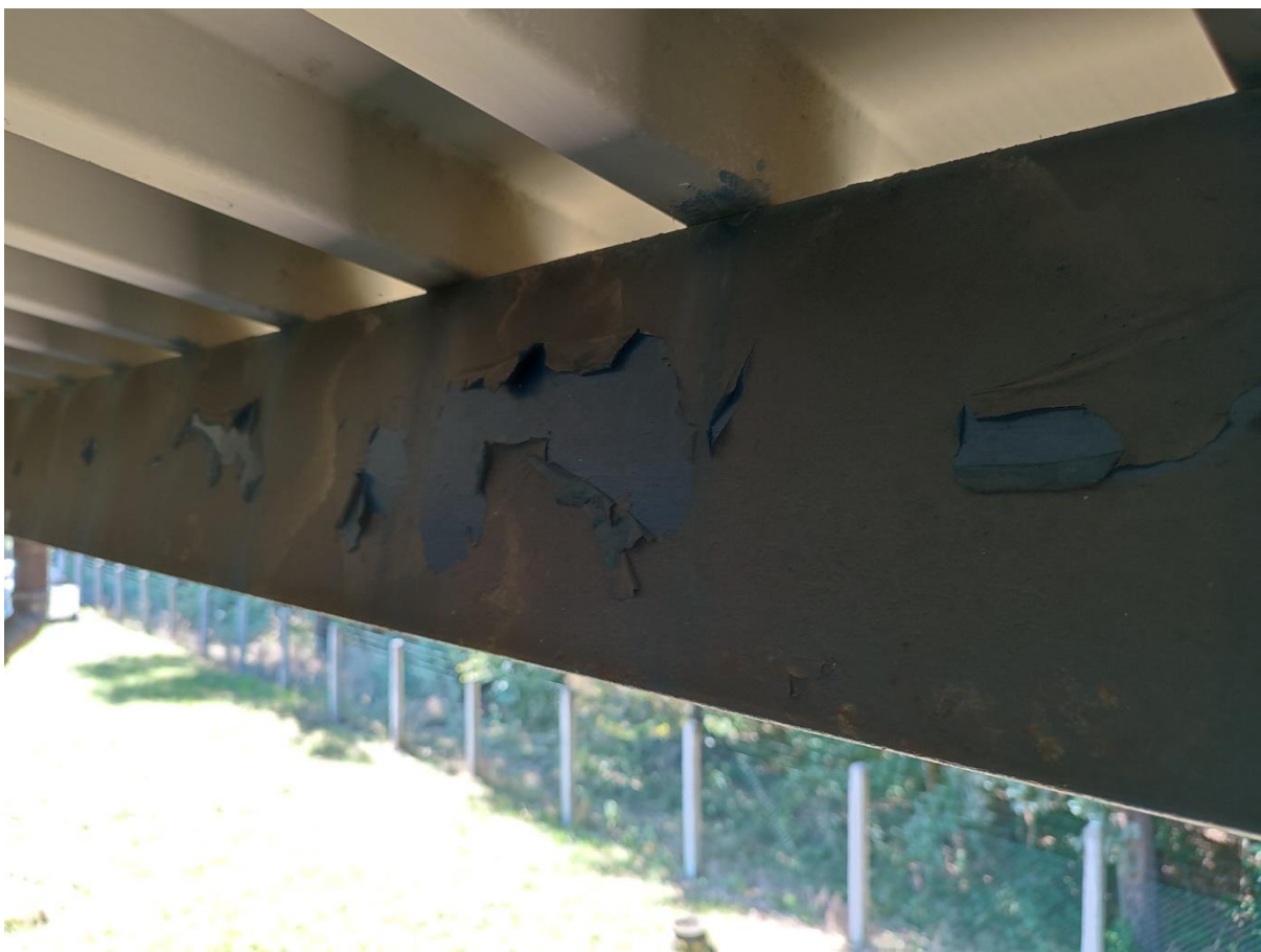
Fot.13 Przykład złuszczeń powłok malarskich na płatwiach
