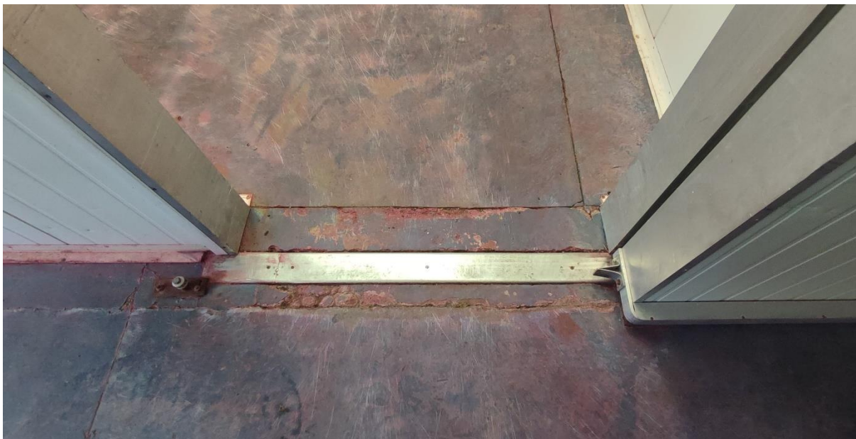
Fot. 10 Przykładowe pęknięcia posadzki w obrębie drzwi
