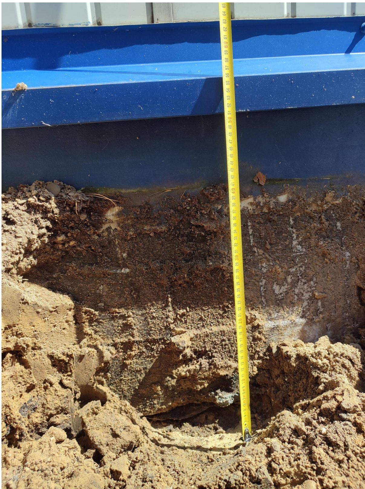
Fot.5 Odkrywka fundamentu – podwalina na folii oraz podbudowie z piasku
