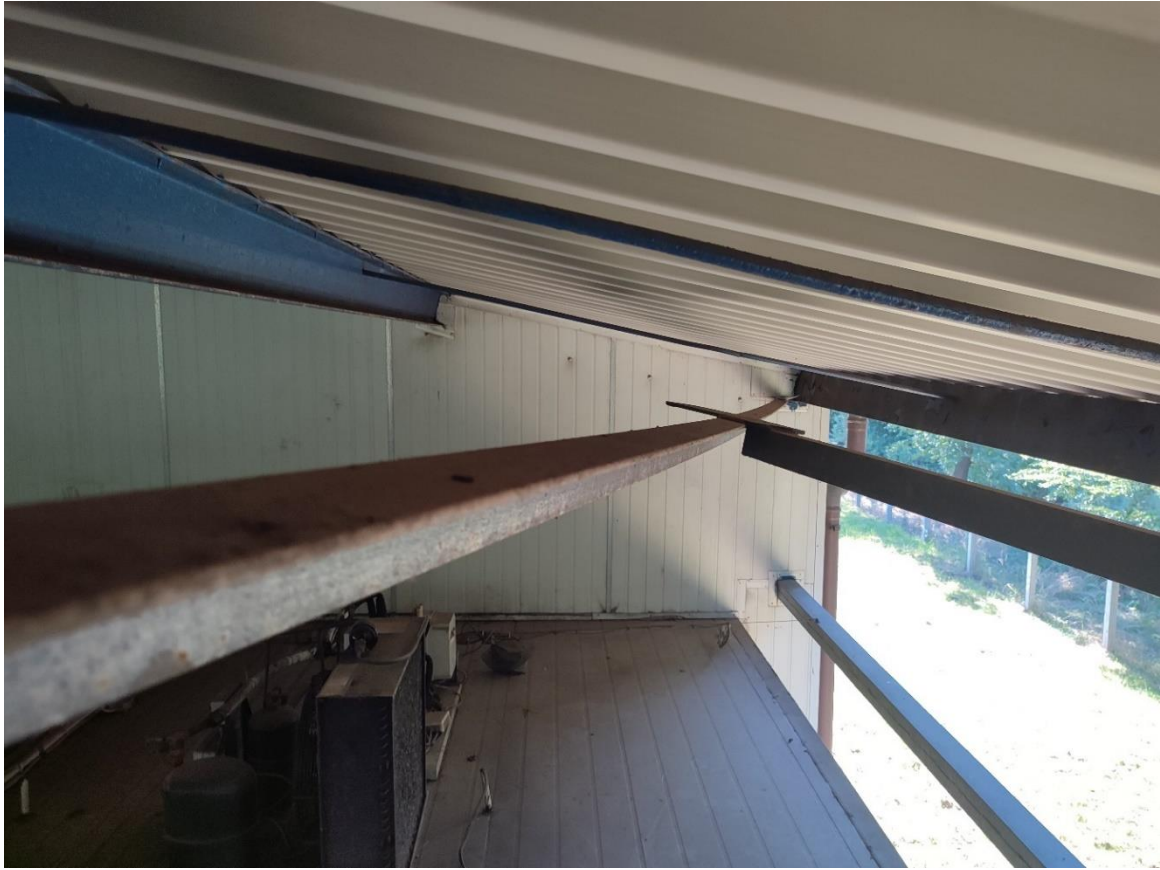
Fot.11 Brak fragmentu stężenia połaciowego w strefie wiaty
