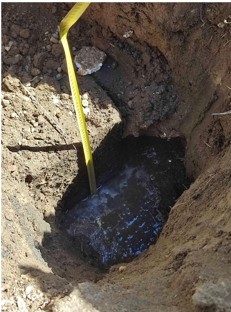
Fot.4 Odkrywka fundamentu – stopa fundamentowa. W poziomie posadowienia woda gruntowa
