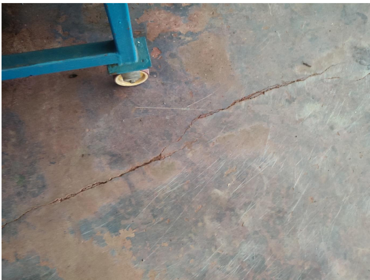
Fot.7 Przykładowe pęknięcia posadzki
